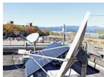
衛星インターネットWiFi設備とソーラー電源
