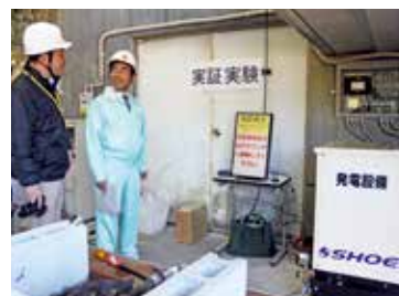
LPガス自家発電機（右）と防災用デジタルサイネージ（中央）
