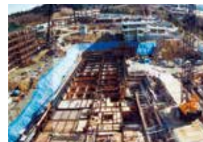
1988年(昭和63年)2期工事中
