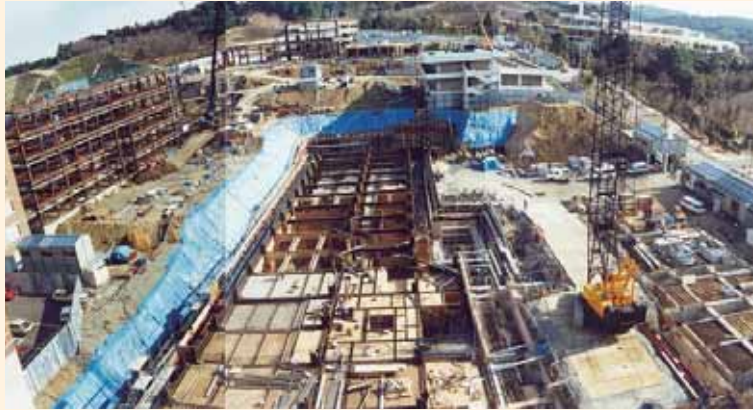
1988年(2期工事中)正面玄関側から講堂方面を望む
