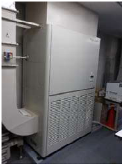
電算機室・電話交換機室空調室内機
