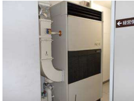
電算機室・電話交換機室空調室内機
