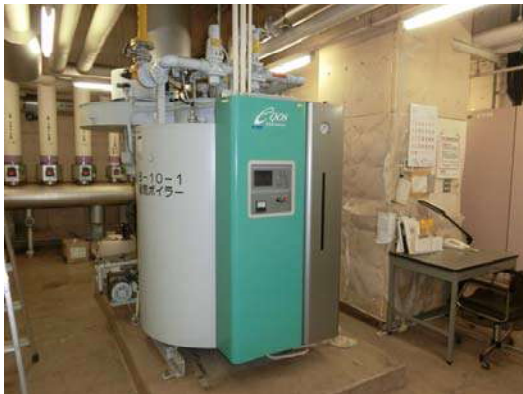
蒸気ボイラー撤去
