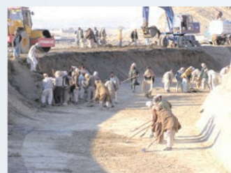
写真：アフガニスタンの用水路工事の様子 (PMS/ベジャワール会提供)
