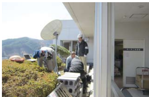
湯瀬准教授の大槌町災害対策本部に衛星インターネットの設置作業
